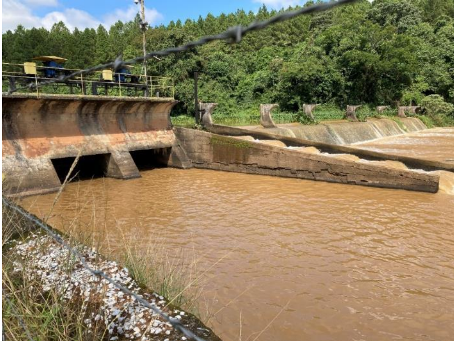
Figura 1 – Vista parcial da barragem da CGH Poço Preto I
