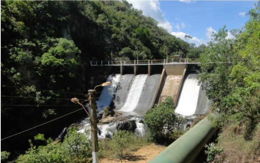
Figura 1 – Vista parcial da CGH Salto da Barra
