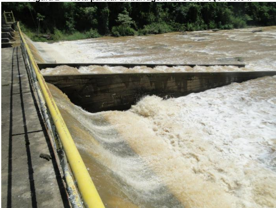
Figura 2 – Vista parcial da barragem da CGH Poço Preto II
